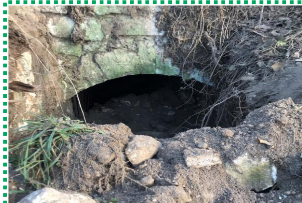
Illustration 4: Création d'un effondrement dû à la présence d'une cavité souterraine (modifié d'après MEED)
