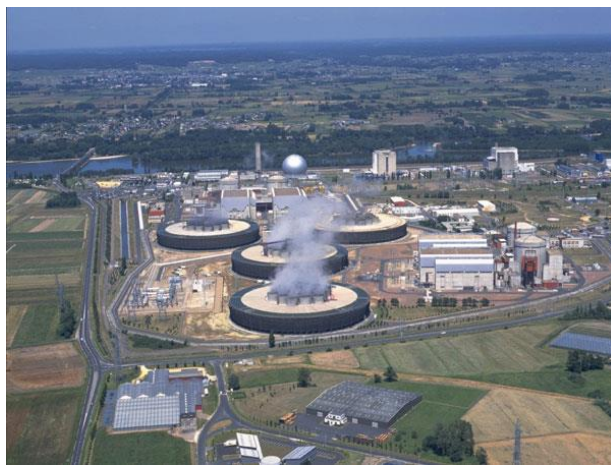
Illustration 13: Centrale Nucléaire de Chinon (Source EDF)
