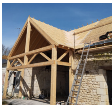
Charpente et extension bois
