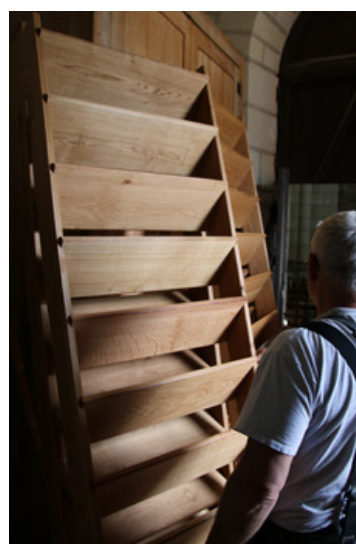
Réalisation et pose des abat-sons en chêne de l'église de Neuillé
