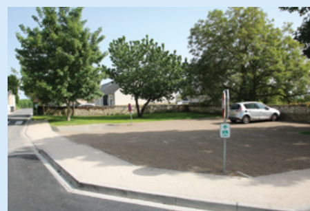
Aménagement de trottoirs et du parking à l'angle des rues de Salvart et du Mûrier
