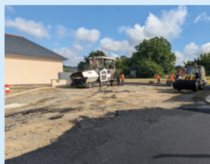
Réalisation des enrobés dans le lotissement des Périnières
