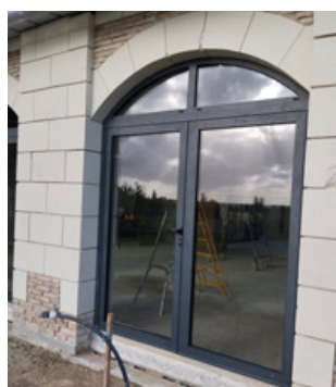
Pose de menuiserie
