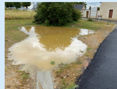
Création d'une noue, rue de Salvart, permettant de collecter l'écoulement des eaux de pluie
