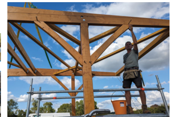
Structure en bois pour un bâtiment agricole
